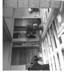
床下のヘドロの引き出し
